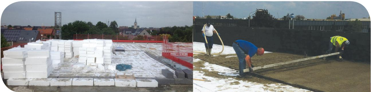
**FIM Leichtausgleich aufgebracht auf EPS-Dämmplatten**
